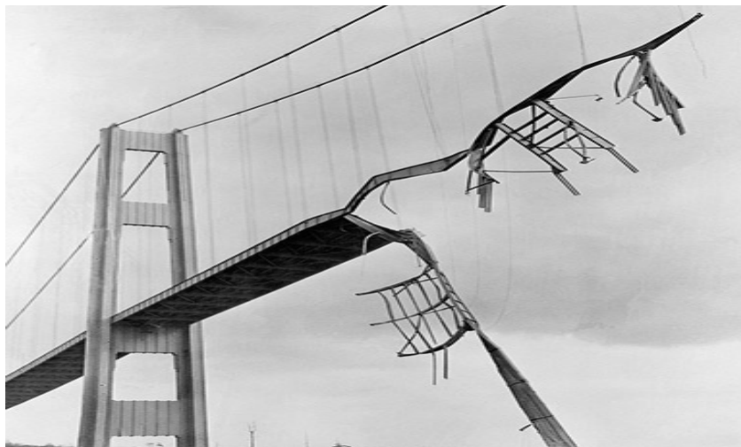
شکل 6,1: خرابی به علت پارگی کابل و افزایش بار بر کابل های همسایه
