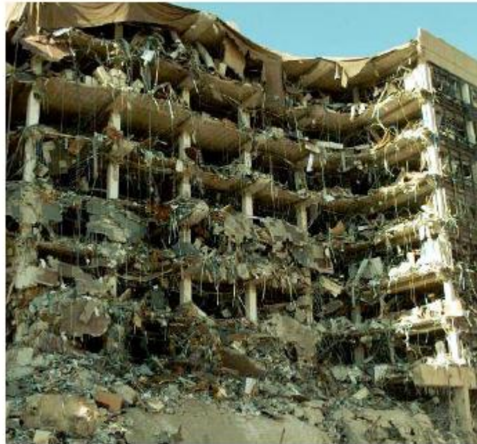
شکل 3,1: ساختمان آلفرد پی موراه پس از خرابی
